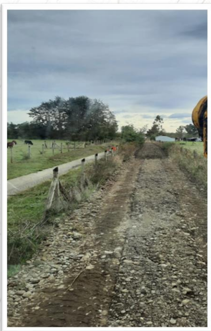
Camino Vecinal Pulón Sector Mahuidanche
