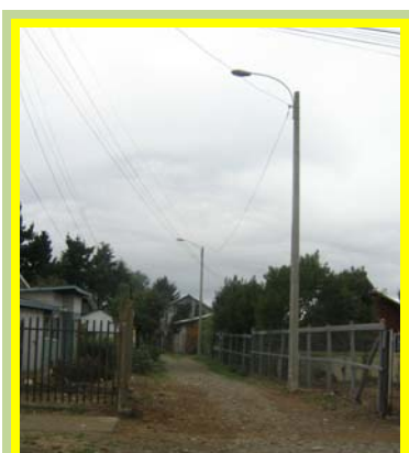
Proyecto "Normalización Alumbrado Publico 6 Sectores Urbanos", Pitrufoquén
