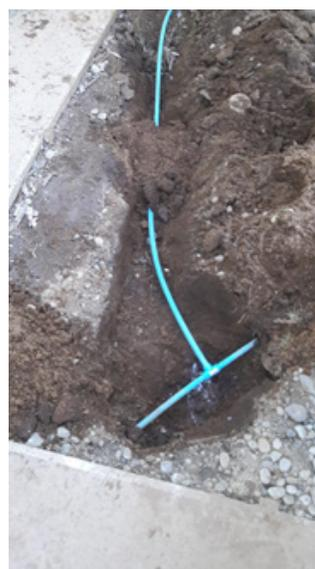
Excavación para realizar conectar los baños del establecimiento a red de agua potable rural. (estaban conectados al pozo en desuso).
